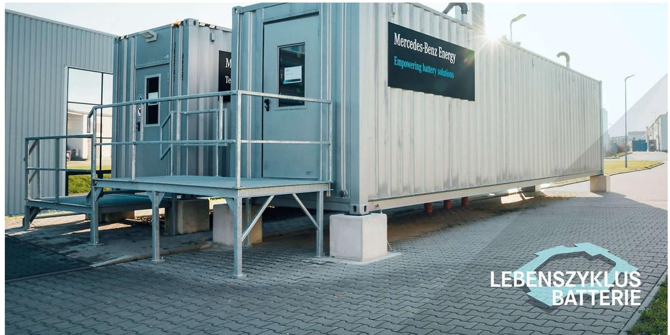
Beispielhafte Abbildung eines Second Life Batteriespeichers als Containerlösung
